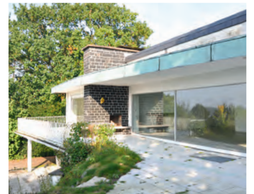
Große Fensterfronten prägen die Architektur des Hauses
