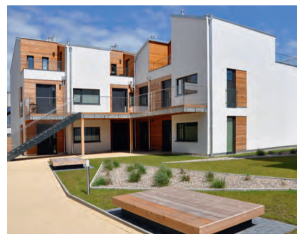
Näher am Geschehen geht es kaum – Anlage »Wilhelmsplatz«
